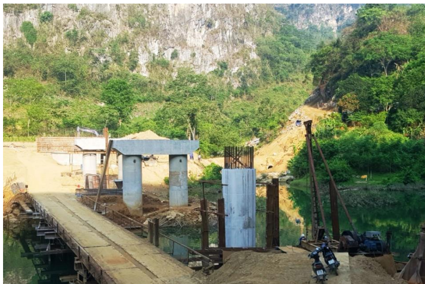
Dự án cầu và đường nối Quốc lộ 34 với xã Nam Quang, Nam Cao (Bảo Lâm) được khẩn trương thi công xây dựng (Năm ?)
