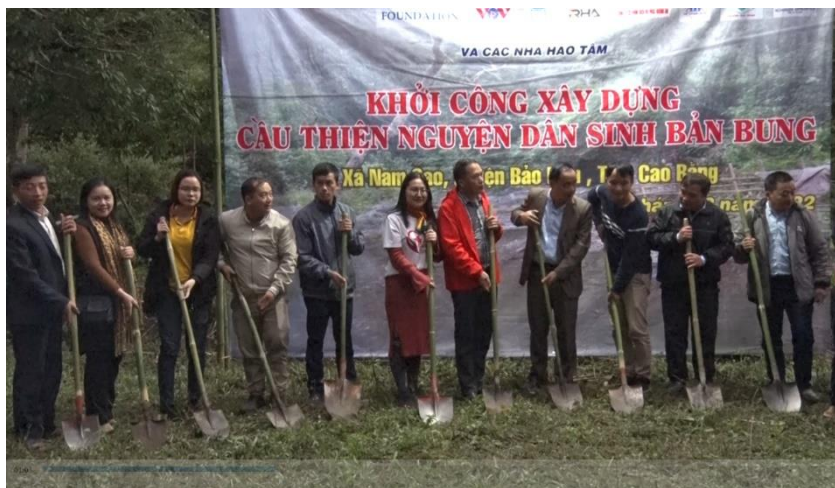
Lễ khởi công xây dựng cầu dân sinh xóm Bản Bung, xã Nam Cao, huyện Bảo Lâm, năm 2022.
